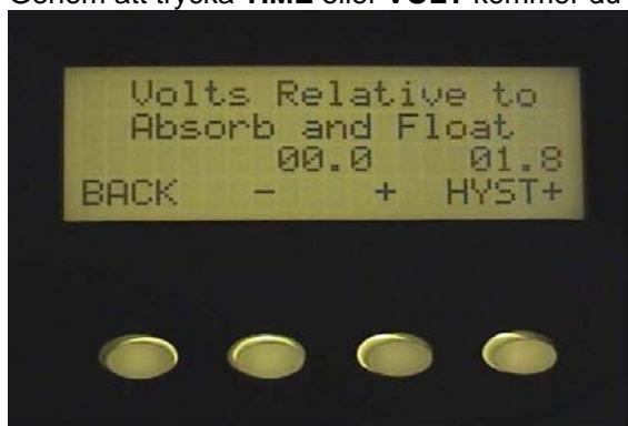
Diversion set up – spänningsinställning
